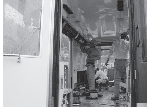
チームに分かれて丁寧に解体していく
